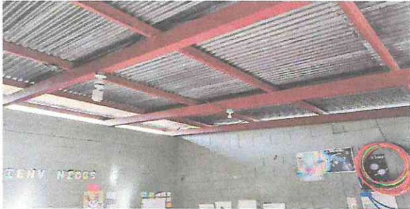
Foto 3: Sustrucion de lamina por lamina troquelada cal 26
