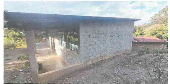
Foto 4: Pintado de paredes
