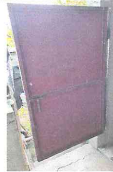
Foto 2: Mantenimiento de puertas de metal en sanitarios
