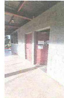
Foto 6: Mantenimiento de puertas de metal en modulos
