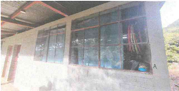
Foto 5: Instalacion de ventanas en PVC
